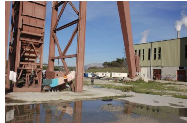
De l'ancien puits, ne restent que le chevalement et le bâtiment électrique. © L.F.
