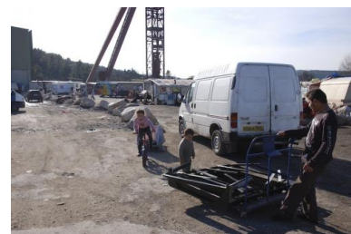
De l'ancien puits, ne restent que le chevalement et le bâtiment électrique. © LF
